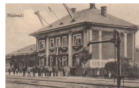
Staré vlakové nádraží v Prostřední Suché na dobové pohlednici z roku 1931
