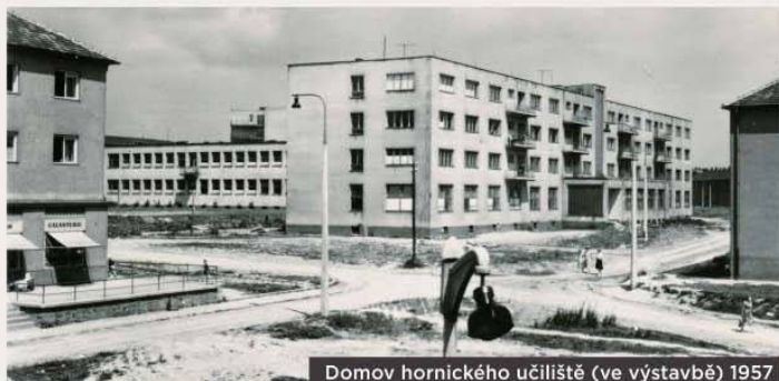
Domov hornického učiliště (ve výstavbě) 1957
